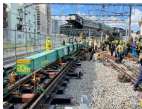
▲鉄道クレーン車(KRC810N)による施工の様子
